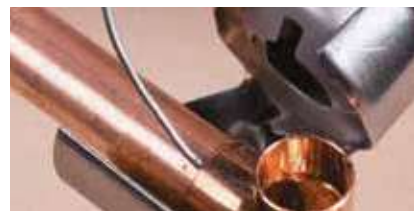
Пайка медных труб (только HG651C, HG551V)
