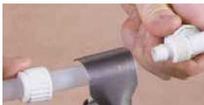
Монтаж пластиковых труб
