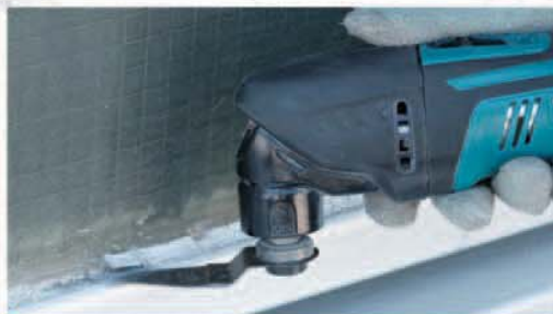
Удаление оконной замазки, герметика
