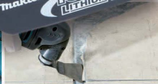
Удаление напольной плитки
