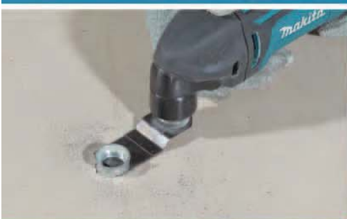
Резка металлических труб заподлицо
