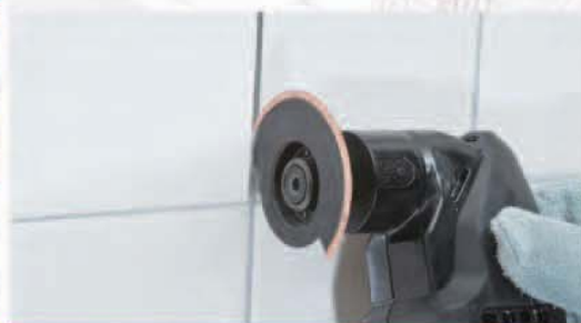
Очистка швов между плиткой
