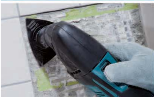
Удаление плиточного клея
