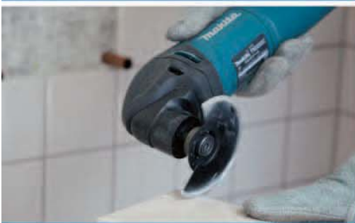
Резка керамической плитки
