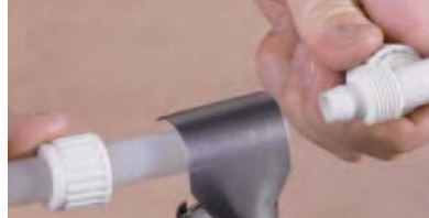
Монтаж пластиковых труб
